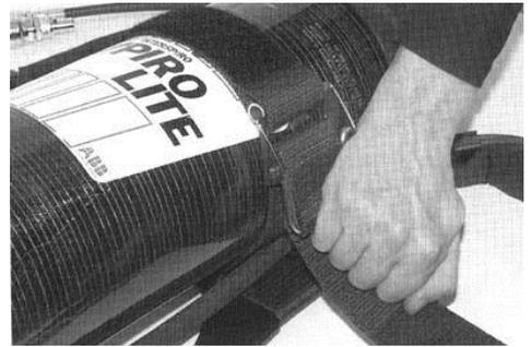
6. Проверьте наличие уплотнительных колец на тройнике и редукторе. Вставьте баллоны в хомут так, чтобы между ними остался разделительный поводок.
