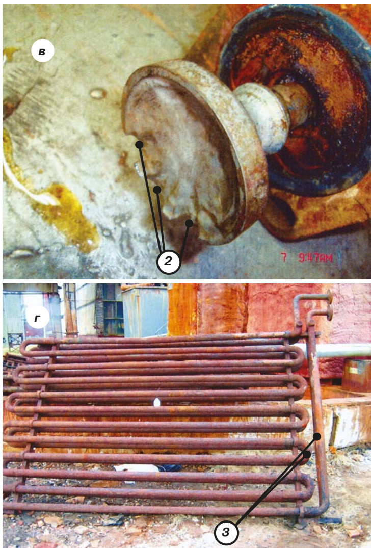
Рис. 5, а–г. Место группового несчастного случая в ОАО «Химпром»: а – общий вид оборудования стадии испарения жидкого хлора (цех № 53): 1 и 2 – резервные испарители поз. З 1 и поз. З 2 (на котором произошла авария); 3 – трубопровод водяной завесы; 4 – работающий испаритель поз. З 3 ; б и в – золотник клапана линии подачи жидкого хлора в испаритель поз. З 2 и корпус клапана: коррозионный износ длиной 7,0 мм и глубиной до 1,5 мм по окружности седла корпуса со стороны выхода среды в трех местах ( 1 ) и до 4,5 мм на \frac{1}{4} длины окружности наружной части золотника на стороне выхода среды в трех местах ( 2 ); г – аварийный змеевик испарителя поз. З 2 (указаны места дефектов)
