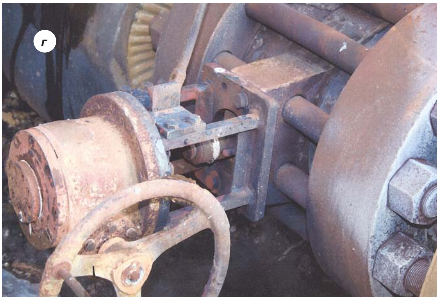
Рис. 4. Разрушения при аварии в ОАО «Череповецкий «Азот»: а и б – общий вид места аварии; в – повреждения колонны синтеза и холодных байпасов; г – заслонка основного хода
