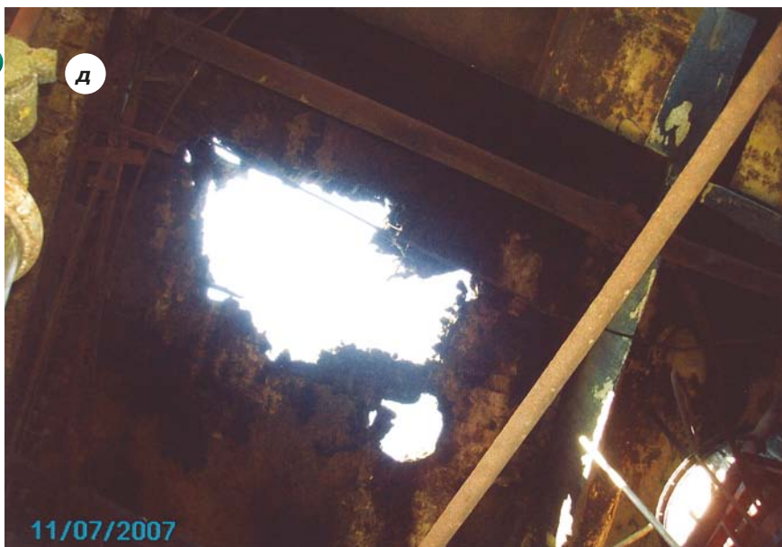
Рис. 2. Последствия аварии в ОАО «Бератон»: а – производственное помещение; б – отделение омыления 2,4-динитрофенола; в – аппарат омыления; г – крышка аппарата омыления; д – повреждение кровли отделения омыления
