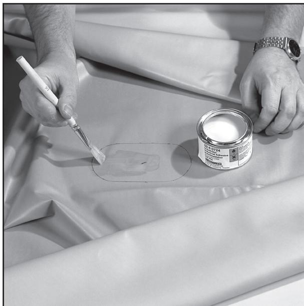
5. Нанесите тонкий слой клея с затвердителем на поврежденную зону и
